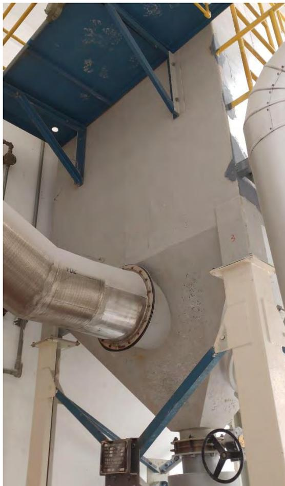
图 2.3-2 加氢石油树脂包装过程的布袋除尘器
