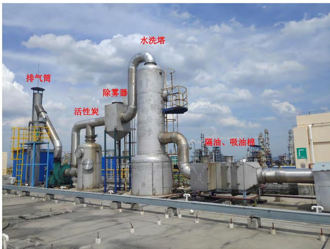
图 9.1-3 造粒废气处理设施
