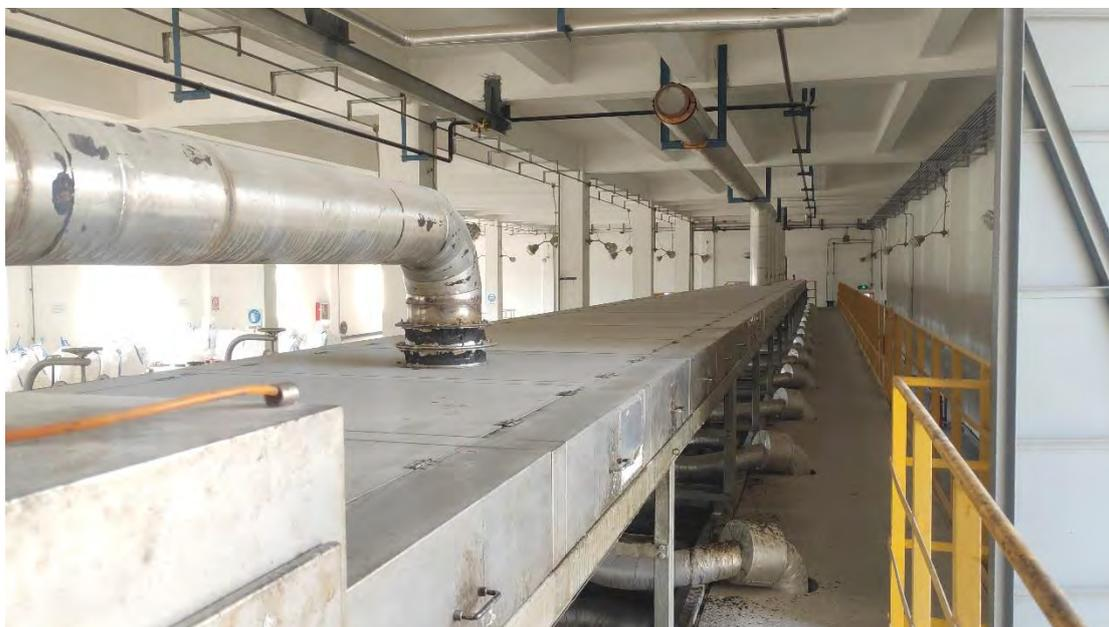
图 9.1-2 现有造粒机集气罩及废气收集系统
